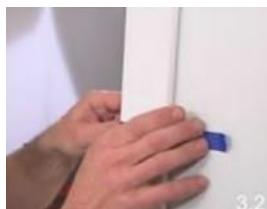
2.5 Nivelez le côté chamière de l'ébrasement avec le mur. aussi bien verticalement qu'horizontalement et fixez cette position temporairement avec des cales au niveau des charnières.
