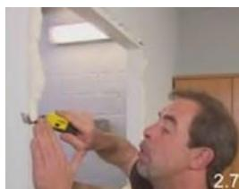
2.4 Calez l'ébrasement temporairement dans l'ouverture dans le mur à l'aide des cales, et cela entre la tête et la partie supérieure de l'ouverture murale.
