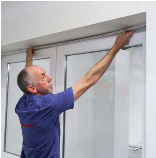
Mesurez la largeur de l'ouverture du châssis.
