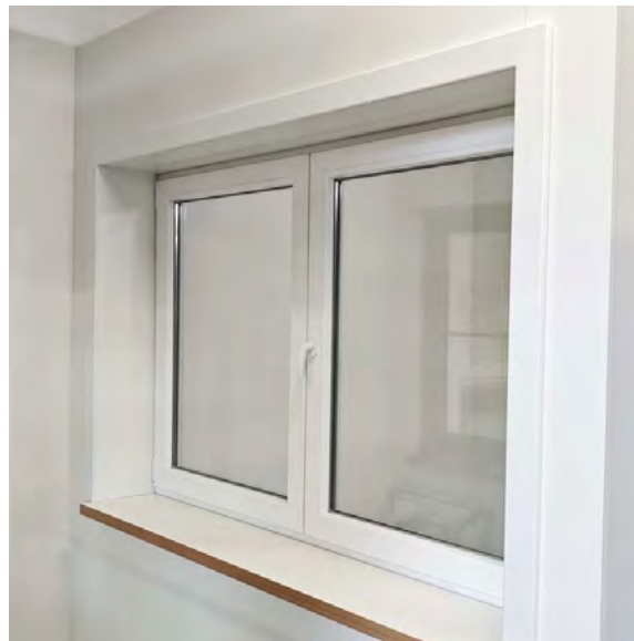
Clipsez la baguette de finition supérieure et faites bien joindre les angles en onglet.
