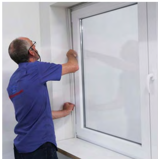
Plaats de verticale profielen met silicone en vijsjes.
