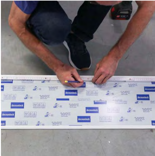
Teken de benodigde lengte af.
