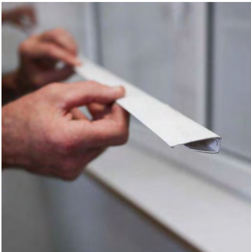
Detail van het U-profiel.
