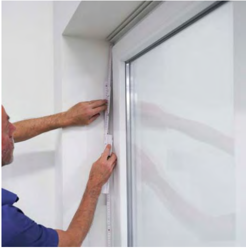
Mesurez la hauteur uniquement après la pose du profilé supérieur.
