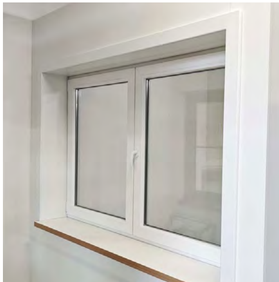
Klik de bovenste afwerkingslijst vast en laat de verstekhoeken aansluiten. Het PVC-raam is rondom afgewerkt met uitkastingsprofielen en afwerkingslijsten.
