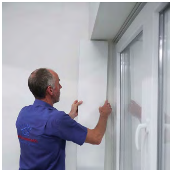
Plaats het verticale uitkastingsprofiel in het U-profiel.
