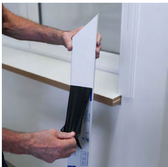
Verwijder de beschermfolie vóór je de lijst vastklikt.
