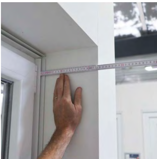
Meet vanaf de binnenzijde van het U-profiel tot aan de muurzijde.
