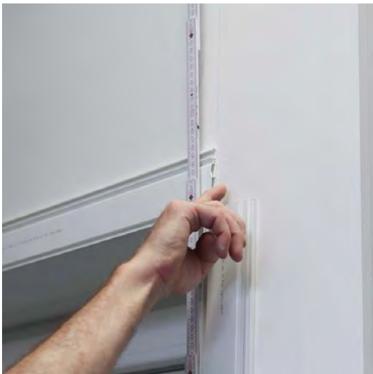
Déterminez la hauteur de la baguette de finition verticale.
