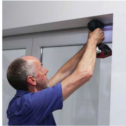
Zet het profiel vast met korte vijsjes.
