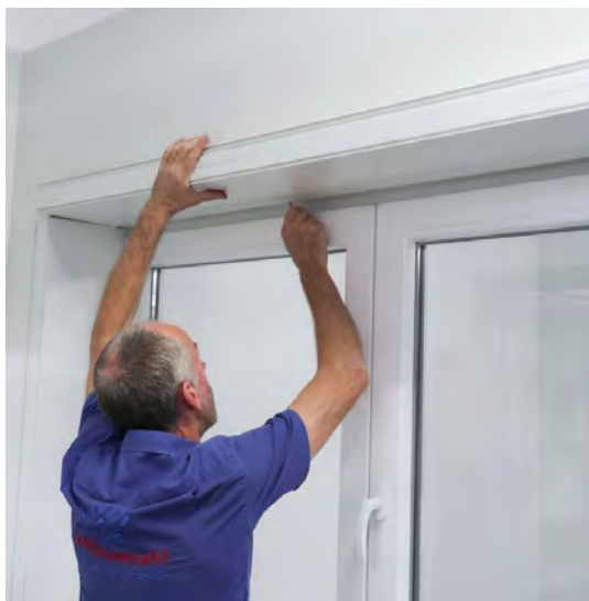
Plaats daarna het horizontale uitkastingsprofiel bovenaan.
