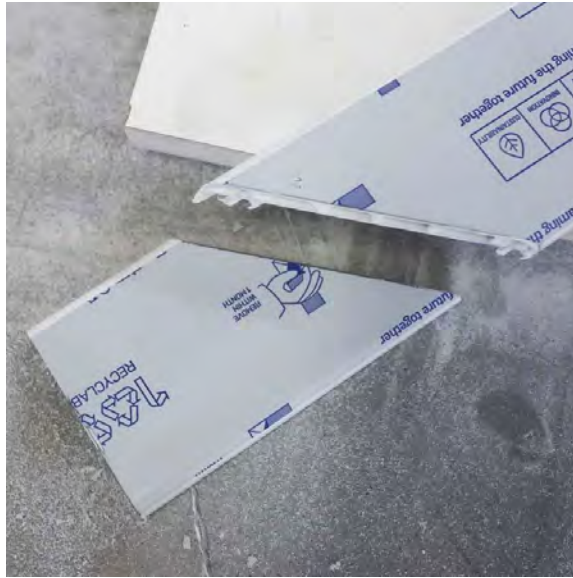
Coupez la baguette de finition à 45° vers l'extérieur.
