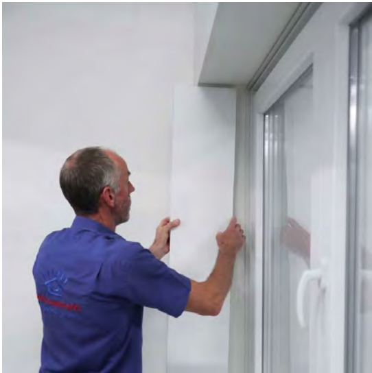
Placez le profilé d'ébrasement vertical dans le profilé en U.
