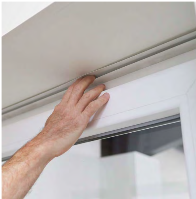
Le profilé en U supérieur est fixé au-dessus du châssis.
