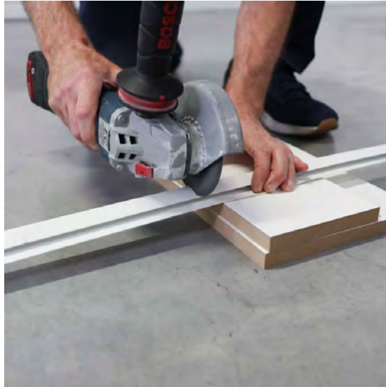
Zaag het U-profiel zorgvuldig op lengte.
