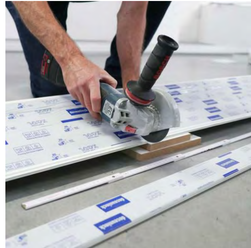
Coupez le profilé d'ébrasement à longueur.
