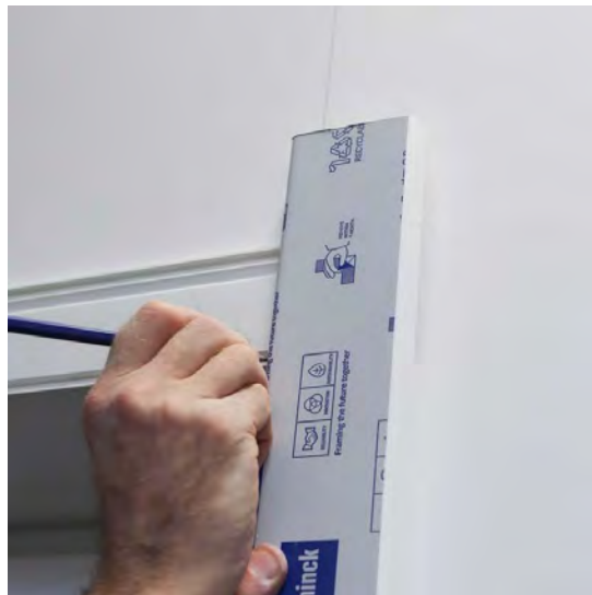
Tracez clairement le point de la coupe d'onglet.
