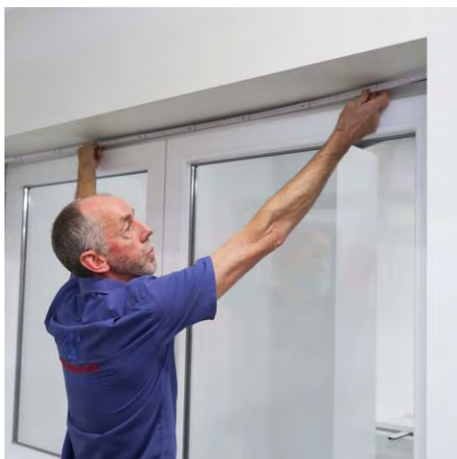
Meet de breedte van de raamopening.
