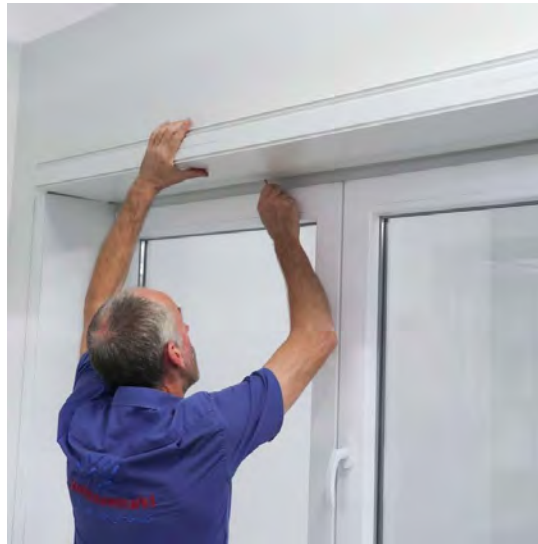
Placez ensuite le profilé d'ébrasement horizontal en haut.
