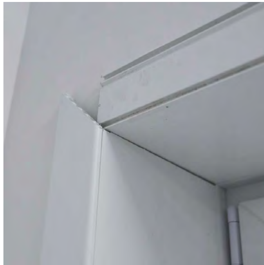
Clipsez la baguette de finition verticale sur le profilé d'ébrasement.
