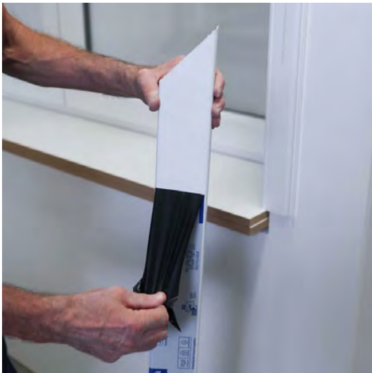
Retirez le film de protection avant de clipser la baguette.
