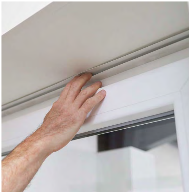
Het bovenste U-profiel wordt vastgezet boven het raam.
