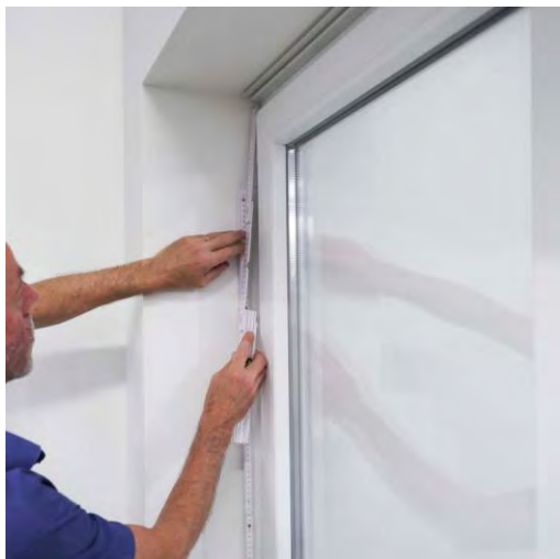
Meet de hoogte pas nadat het bovenprofiel geplaatst is.
