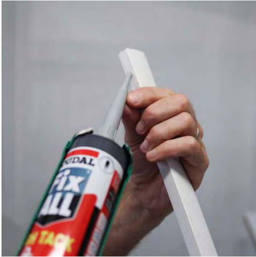
Silicone à l'arrière du profilé.
