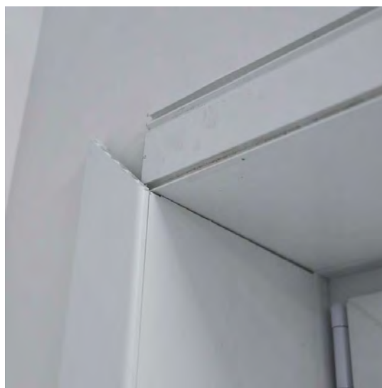
Klik de verticale afwerkingslijst op het uitkastingsprofiel.
