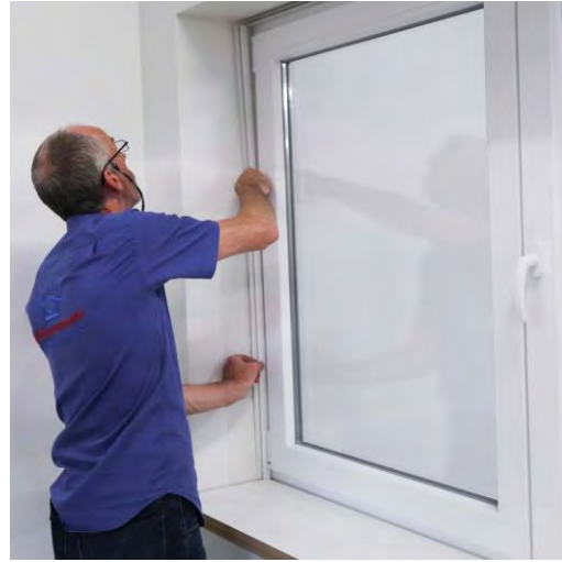
Posez les profilés verticaux avec du silicone et de petites vis.
