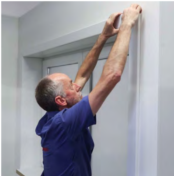
Clipsez la baguette de finition supérieure et faites bien joindre les angles en onglet.
